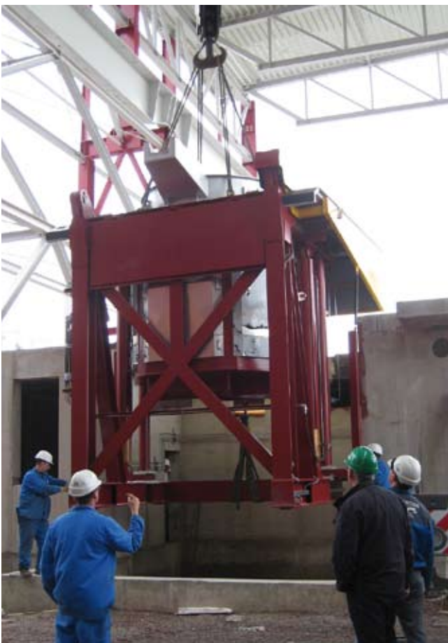
Höchste Präzision ist bei der Montage eines Tiegelofens gefordert
