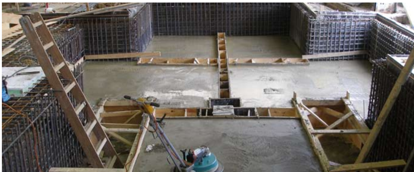
Fundamentarbeiten für das neue Bearbeitungszentrum
