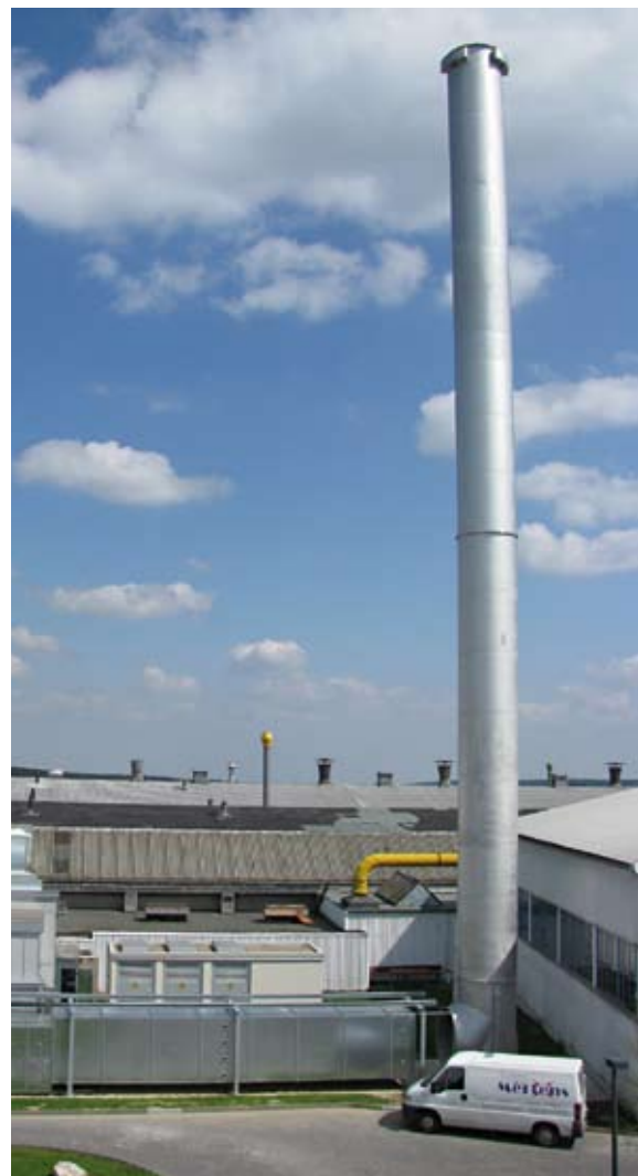
Fertiggestellte Außenanlagen mit Kamin
