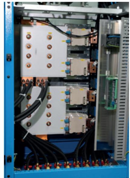
IGBT-Umrichteranlage für 3.000 kW
